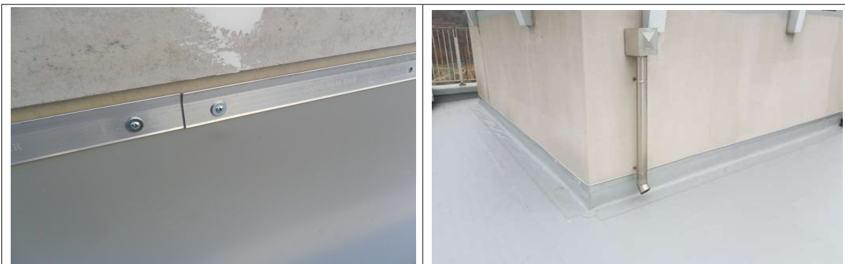
[사진4] TR-Bar(후레싱) 시공
