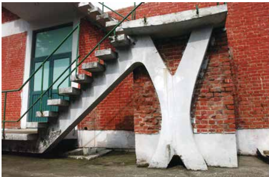
사무동 뒤편의 계단. 계단이 건물로부터 돌출하듯이 설치되었다. 이를 받치는 구조도 쌍 와이자를 살렸다.
