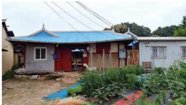
현재 농촌에서 진행되고 있는 농가주택의 경관 및 기능변화 모습. 지붕은 초가에서 개량형 기와 또는 양철지붕으로, 벽체와 창호는 현대식으로, 지붕처마 옆 공간을 수납공간으로 활용하기 위해 컨테이너박스를 가져다 놓았다.(등원리 소재)
